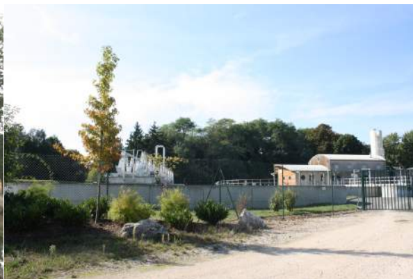
Des éléments de la station d'épuration contrastés
