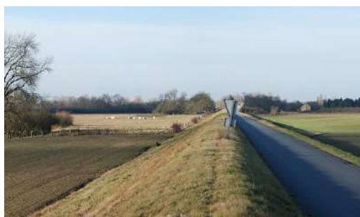
Figure 28 : Levée séparant des pâturages et des terres de grande culture
