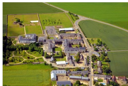
Hôpital de Neuville-aux-Bois
