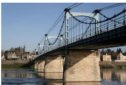
Pont de Châteauneuf-sur-Loire
