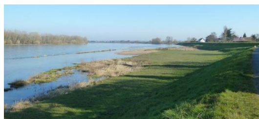
Levée en berge rive droite de la Loire à St-Benoît-sur-Loire
