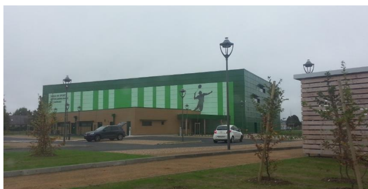
Gymnase intercommunal à Darvoy
